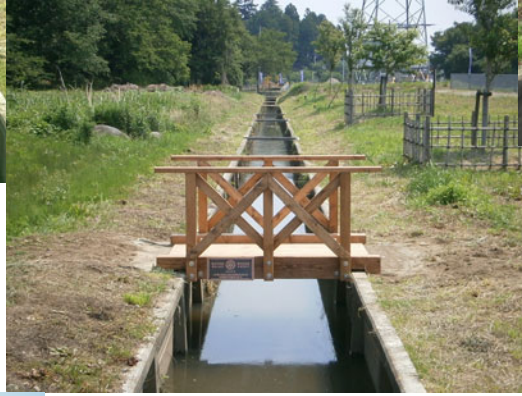
②架橋後の様子
